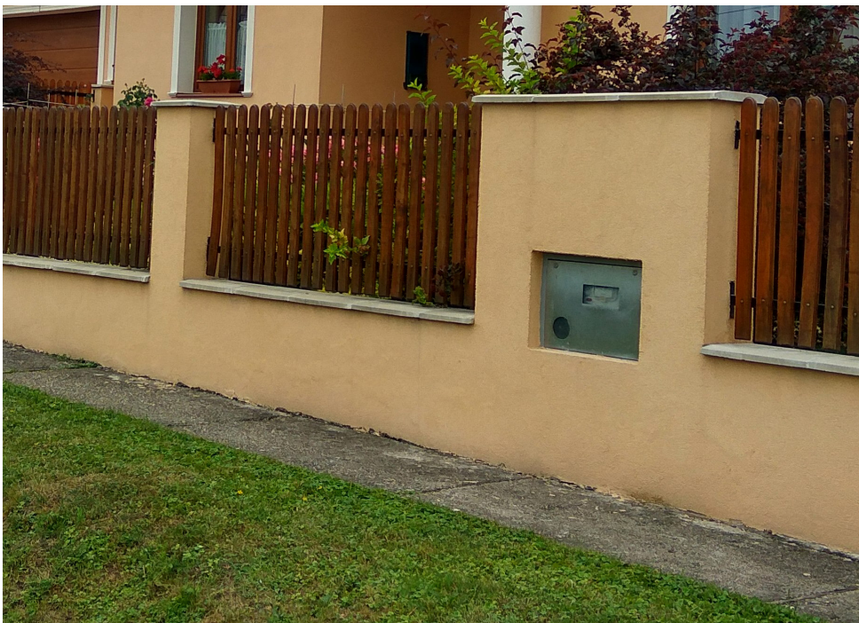
[71] TETŐCSERÉPPREL EGY SZINTBEN KIALAKÍTHATÓ NAPELEM [72] AZ EGRÍ ÚTI LAKÓPARK JELLEMZŐ MÉRŐÓRA ELHELYEZÉSE fotó: Poltrade Bt
