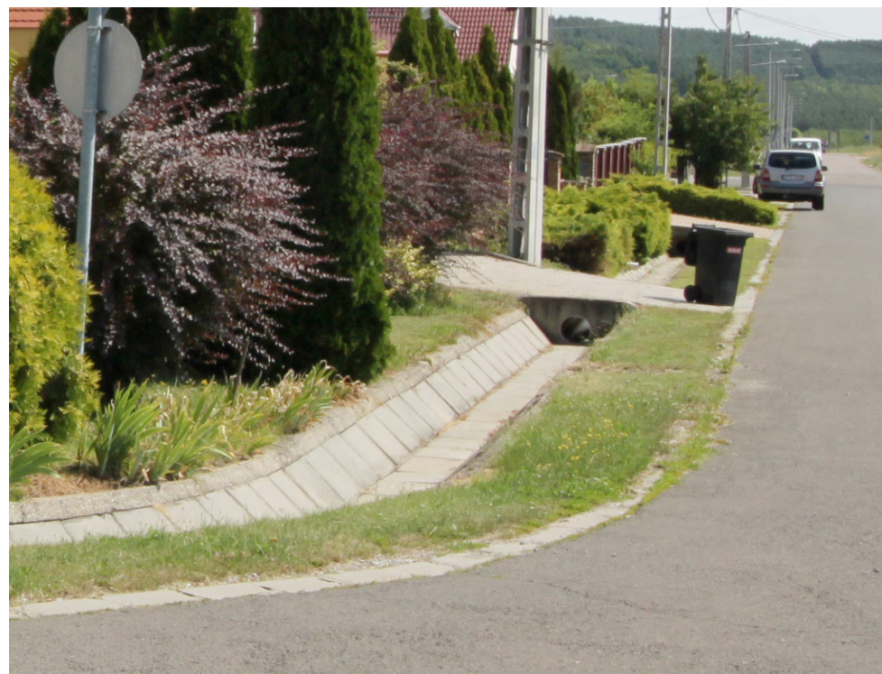
[100] [6] AZ UTCAI VÍZELVEZETŐ FOLYÓKÁK VESZIK FEL A TELKEN BELÜLI CSAPADÉKOT IS fotó: Tunnel Kft.
