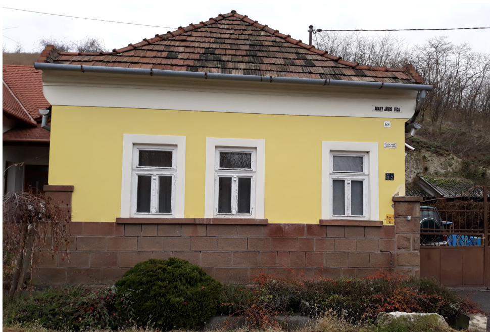
[35] FÜLESHÁZ HOMLOKZATA fotó: Ostoros Önkormányzata (Vasas Ágostonné)
