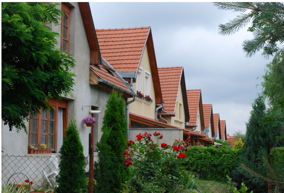
[25] ZÁRTSORÚ LAKÓHÁZSOR HÁTSÓ HOMLOKZATA fotó: Grafit Műterem Kft.
