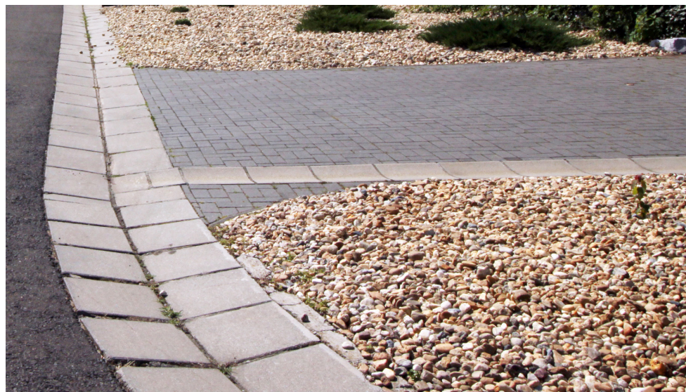
[100] [6] AZ UTCAI VÍZELVEZETŐ FOLYÓKÁK VESZIK FEL A TELKEN BELÜLI CSAPADÉKOT IS fotó: Tunnel Kft.
