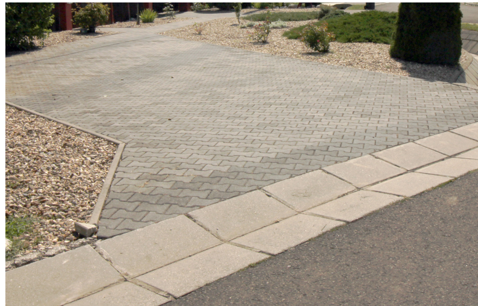
[105] A TÚLZOTT BURKOLÁS, A CSAPADÉKVÍZ ELVEZETÉSE ÉS A KAVICSTERÍTÉS FELBORÍTTJA A TALAJ TERMÉSZETES VÍZHÁZTARTÁSÁT fotó: Tunnel Kft.
