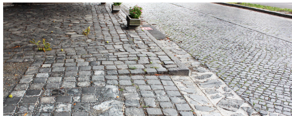
[144] HELYI BAZALT TERMÉSKŐ ALKALMAZÁSA BADACSONYTÖRDEMIC KÖZPONTJÁBAN: FORGALOMCSILLAPÍTOTT ÚTPÁLYA: KISKOCKA (JOBBRA) JÁRDA: FELEZETT NAGYKOCKA (KÖZÉPEN) ÉS SZABÁLYTALAN KŐ BAZALTZÚZALÉK HÉZAGOLÁSSAL (BALRA FENT) PUFFER TERÜLET: BAZALT ZÚZALÉK (BALRA LENT) KERÜLENDŐ PÉLDA: BETONBA RAKOTT SZABÁLYTALAN TERMÉSKŐ NAGY FUGÁKKAL Fotó: Tunnel Kft.
