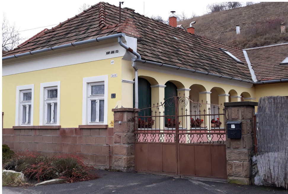
[42] HOSSZOLDALI OLDALTORNÁC FALUSIAS KARAKTERBEN fotó: Ostoros önkormányzata (Vasas Ágostonné)
