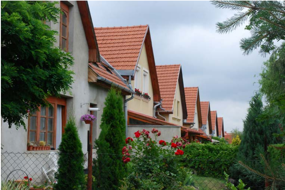
[20] ZÁRTSORÚ LAKÓHÁZSOR HÁTSÓ HOMLOKZATA fotó: Grafit Műterem Kft.
