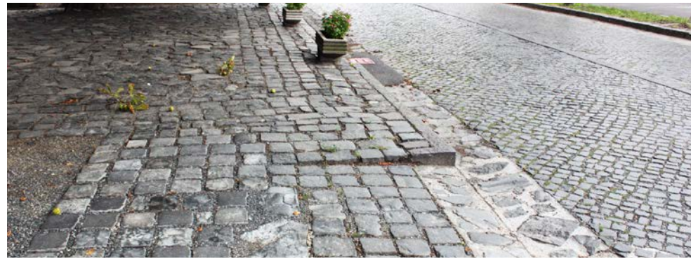
[138] HELYI BAZALT TERMÉSKŐ ALKALMAZÁSA BADACSONYTÖRDEMIC KÖZPONTJÁBAN: FORGALOMCSILLAPÍTOTT ÚTPÁLYA: KISKOCKA (JOBBRA) JÁRDA: FELEZETT NAGYKOCKA (KÖZÉPEN) ÉS SZABÁLYTALAN KŐ BAZALTZÚZALÉK HÉZAGOLÁSSAL (BALRA FENT) PUFFER TERÜLET: BAZALT ZÚZALÉK (BALRA LENT) KERÜLENDŐ PÉLDA: BETONBA RAKOTT SZABÁLYTALAN TERMÉSKŐ NAGY FUGÁKKAL Fotó: Tunnel Kft.
