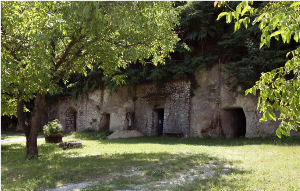
[123] PINCESOR OSTOROS NOVAJ FELŐLI KAPUJÁNÁL fotó: Tunnel Kft.
