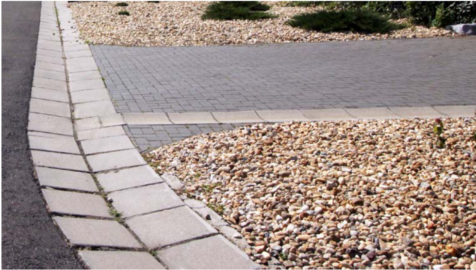
[96] [6] AZ UTCAI VÍZELVEZETŐ FOLYÓKÁK VESZIK FEL A TELKEN BELÜLI CSAPADÉKOT IS fotó: Tunnel Kft.
