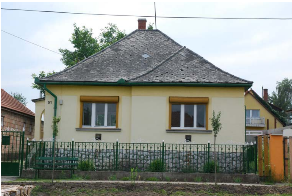
[16] KOCKAHÁZ UTCAI HOMLOKZATA fotó: Grafít Műterem Kft.
